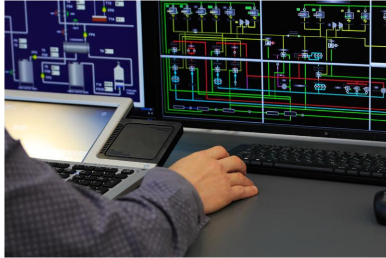
Implantation d'un système de surveillance – Type SCADA
