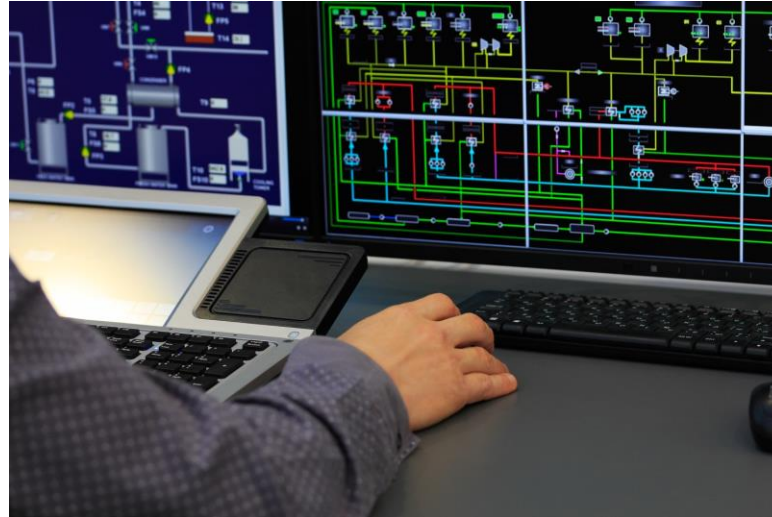
Implantation d'un système de surveillance – Type SCADA
